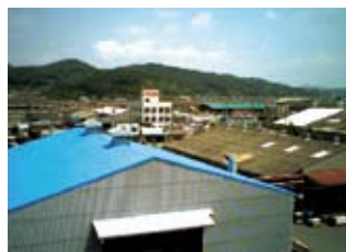
遮熱塗料施工後（手前の青い屋根）
